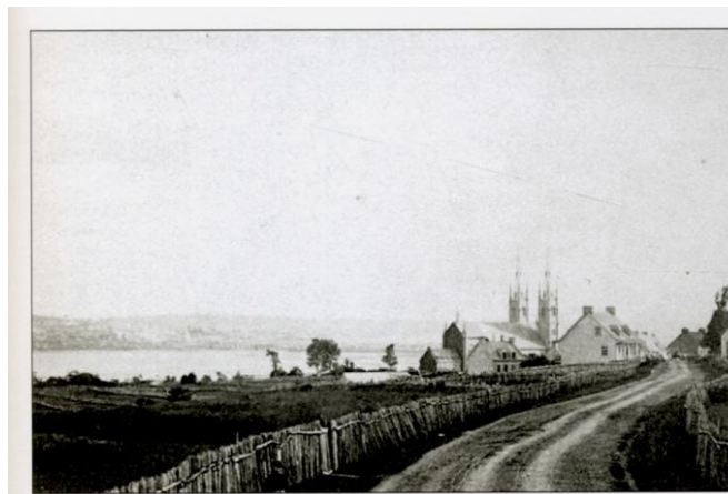
Figure 31. Vue vers l'ouest de la troisième église de Beauport à partir de l'avenue Royale vers 1870 (BAnQ P1000, S4, D59, P101)
